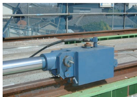
橋桁送り出し (レールクランプジャッキによる)
