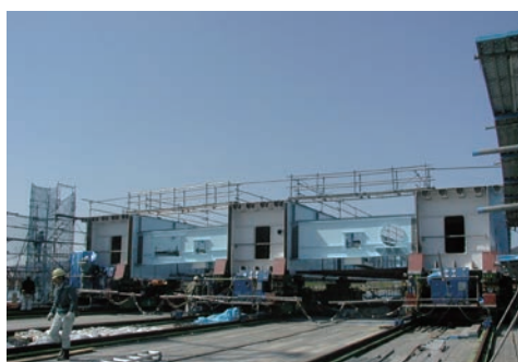
橋桁送り出し (レールクランプジャッキによる)
