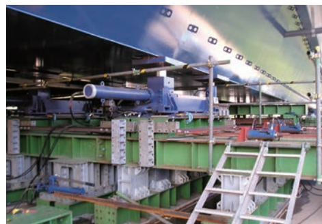
橋桁送り出し (桁送り出し装置による)
