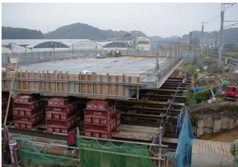
ジャッキダウン据付 (変位自動制御システム)
