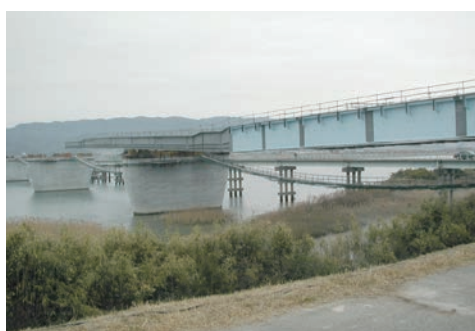
橋桁送り出し (エンドレス滑り装置による)
