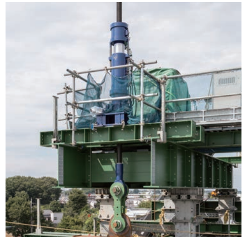
橋桁の吊り降ろし (ジャッキングホイストによる)
