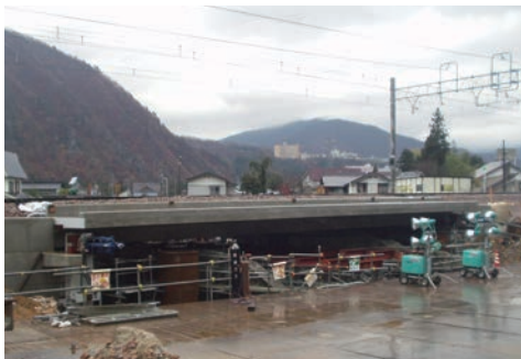
PC 桁横取り (ダブルツインジャッキによる)
