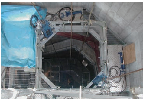
内筒管リフトアップ (ストランドチャッキングシステム)
