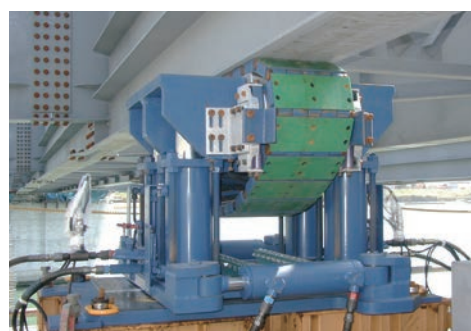
橋桁送り出し (エンドレス滑り装置による)
