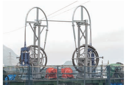
橋桁のリフトアップ (ダブルツインジャッキによる)
