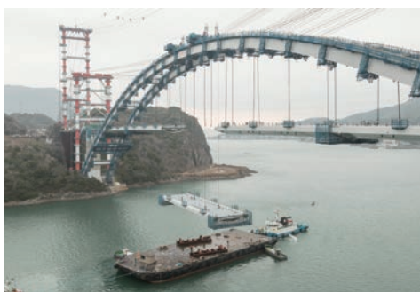
橋桁のリフトアップ (ダブルツインジャッキによる)
