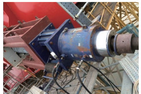
斜張橋 (ケーブル引込ジャッキによる)
