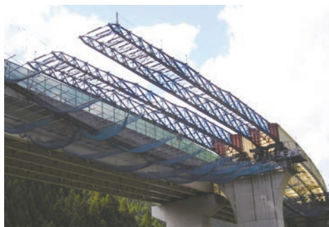
橋桁送り出し (桁送り出し装置による)
