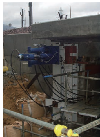
PC 桁横取り (ダブルツインジャッキによる)
