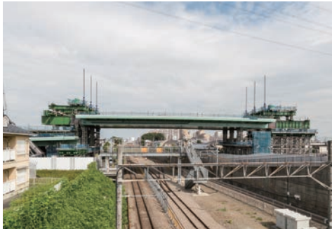
橋桁の吊り降ろし (ジャッキングホイストによる)
