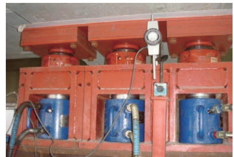
アンダーピニング (簡易型アンピンジャッキ)
